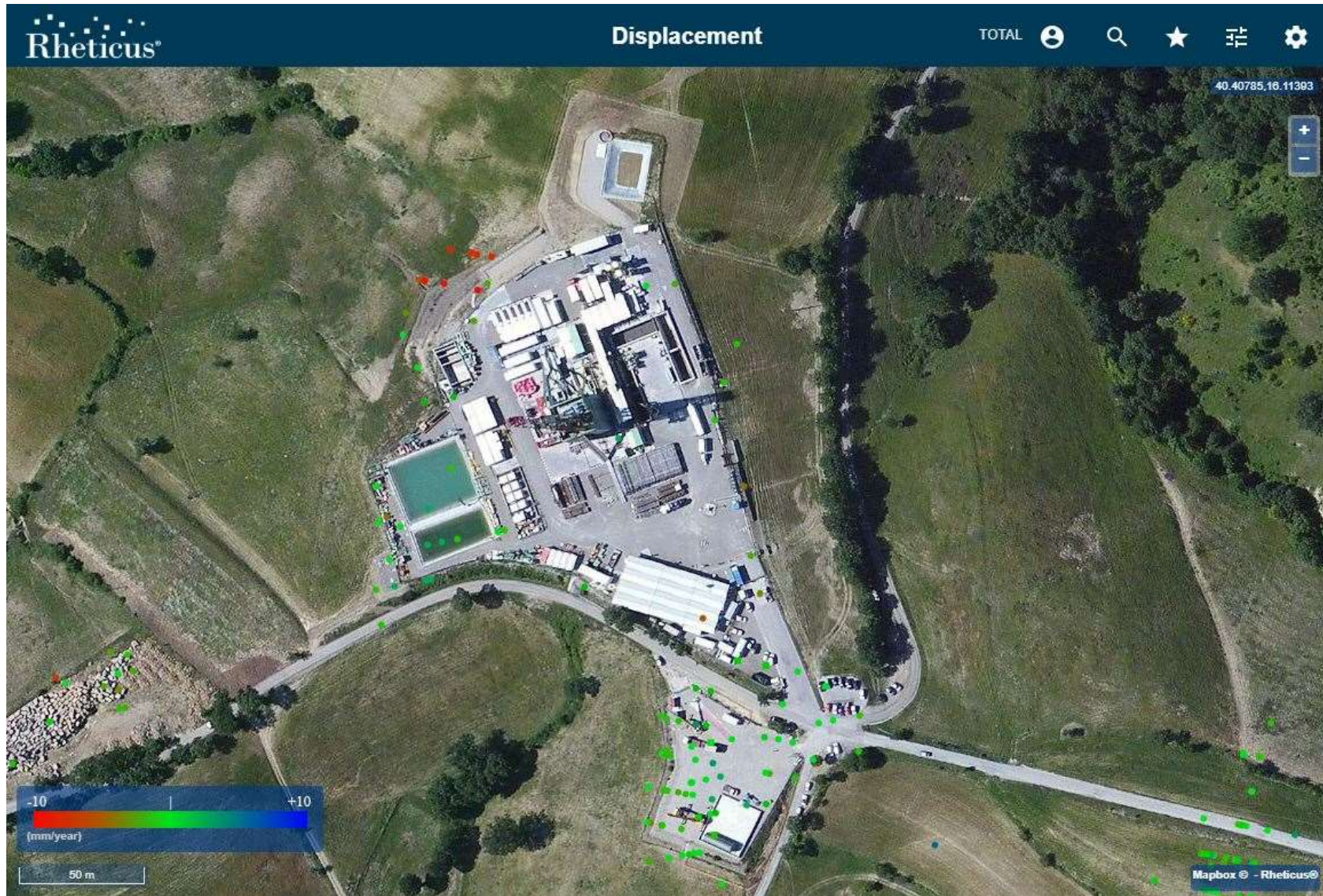
Figura 25: Pozzo GG-2 caratterizzato da una buona copertura di PS e dai quali si evince la stabilità del piazzale ad eccezione della zona a nord ovest che presenta movimenti con velocità medie misurate lungo la LOS in orbita descending comprese tra -7 e -10 mm/anno nel periodo Ottobre 2014 – Giugno 2018.
