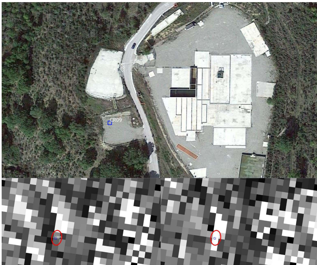
Figura 49: In alto l'immagine con la posizione del CR-09 (quadrato blu) installato a ovest del piazzale TR-2. Dal confronto di intensità sull' orbita Ascending pre (immagine in basso a sinistra acquisita il 26 luglio 2018) - post installazione (immagine in basso a destra acquisita il 31 Agosto 2018) si nota un netto miglioramento della risposta in ampiezza sulla zona in prossimità del CR (zona evidenziata dai cerchi rossi).
