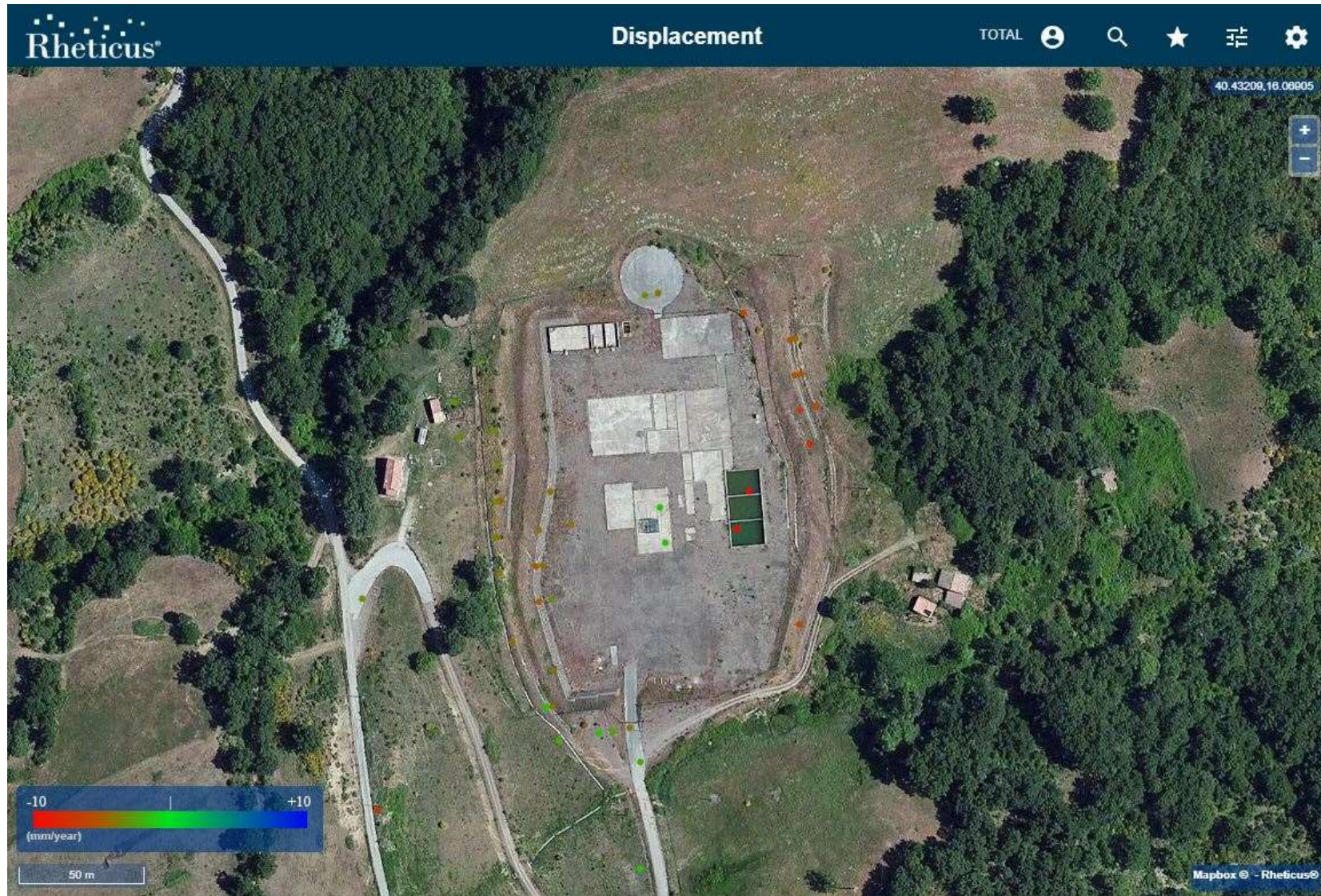
Figura 27: Pozzo TE-1 caratterizzato da una buona copertura di PS e dai quali si evincono movimenti medi diffusi misurati lungo la LOS Ascending caratterizzati da una velocità media pari a circa -5 mm/anno nel periodo Ottobre 2014 – Giugno 2018
