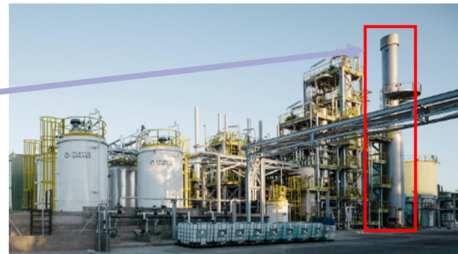
Nouvelle cheminée pyrolyse 25 m
