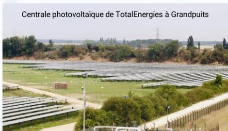
TotalEnergies a construit sur 12 ha une centrale photovoltaïque générant annuellement 31 GWh, correspondant à la consommation de 19 200 habitants, ainsi qu'un système de stockage d'énergie par batterie de 43 MW pour soutenir le réseau RTE.
