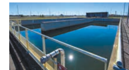
Bassin de récupération des eaux de pluie de la centrale à cycle combiné au gaz naturel de Bayet
