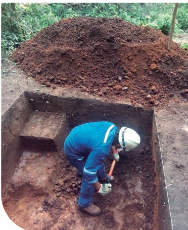
Excavación de diagnóstico en área del futuro proyecto de Línea de recolección ICS-5.
