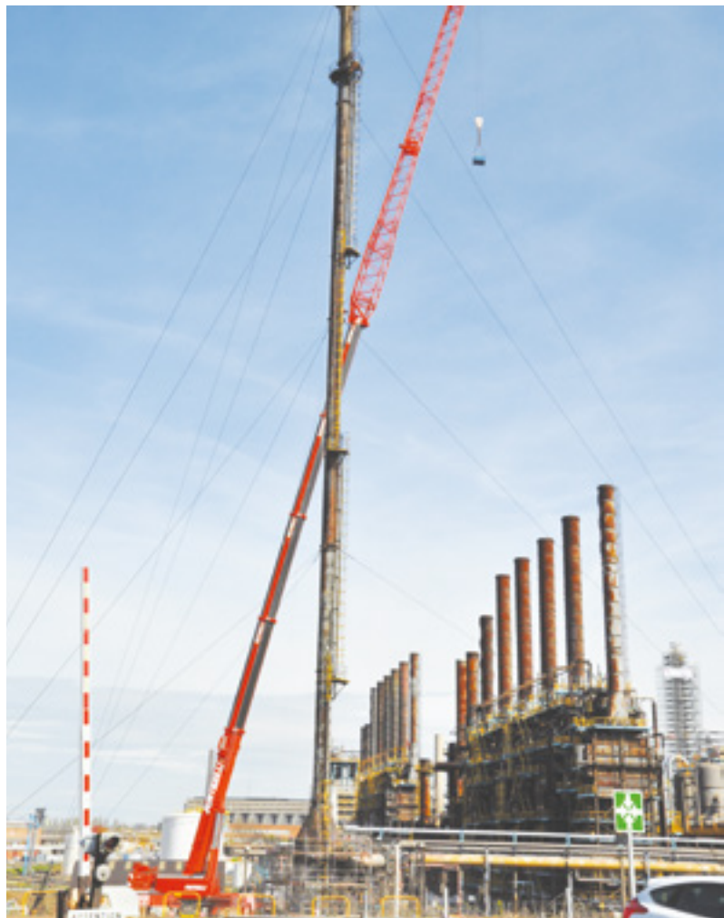
Grand arrêt de maintenance TOPAZE - 2013
