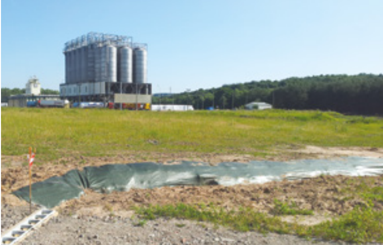
Barrière empêchant les pélobates bruns d'accéder au chantier PPA
