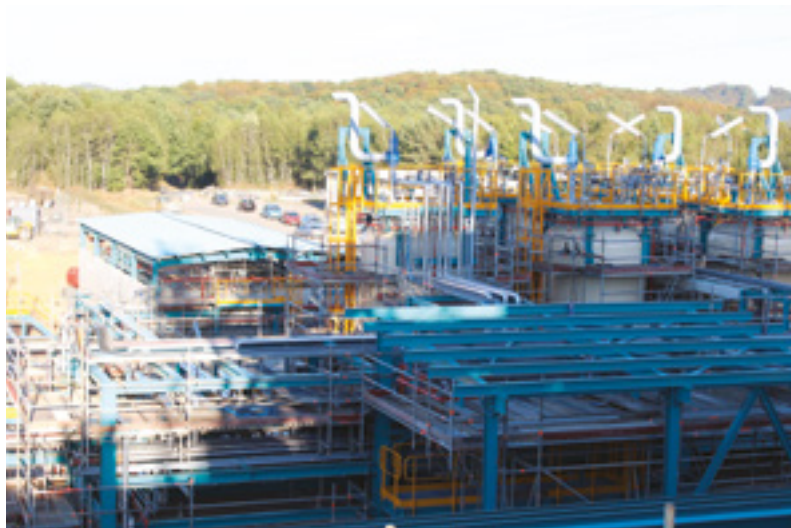
Chantier de construction de l'unité Résines Krasol® et Ricon® - octobre 2016
