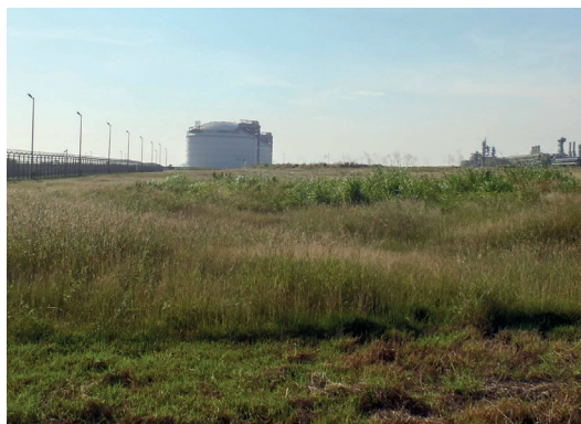
Plate ES2 LNG Plant site with LNG tanks, facing north
