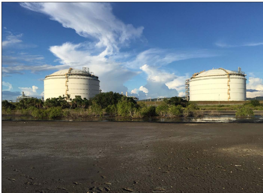
Plate 2.5 LNG storage tanks
