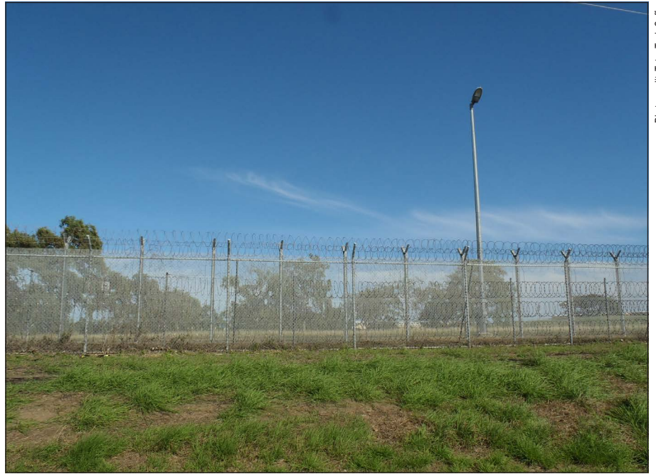
Plate 2.7 LNG Plant security fence
