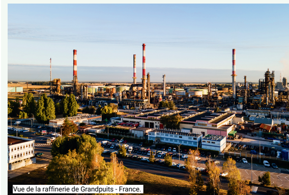
Vue de la raffinerie de Grandpuits - France.
