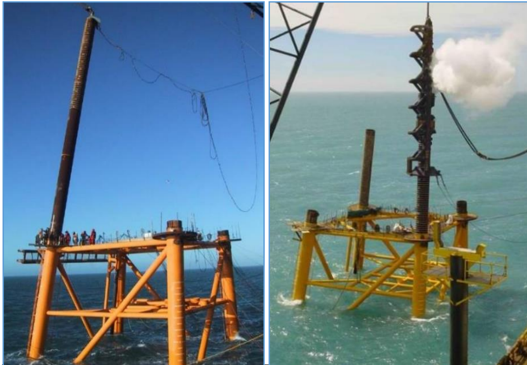
Figura 4.5.1.3.1 Hincado de pilotes con martillo de vapor para VP. Fuente: Total Austral
