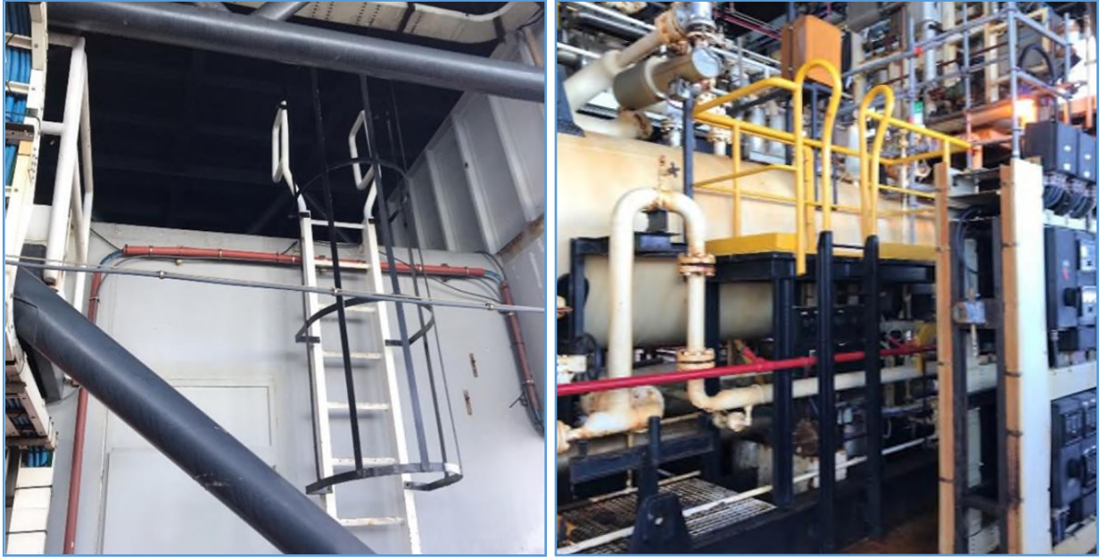
Figura 4.9.1.3 Inspección de estructuras terciarias de la plataforma
