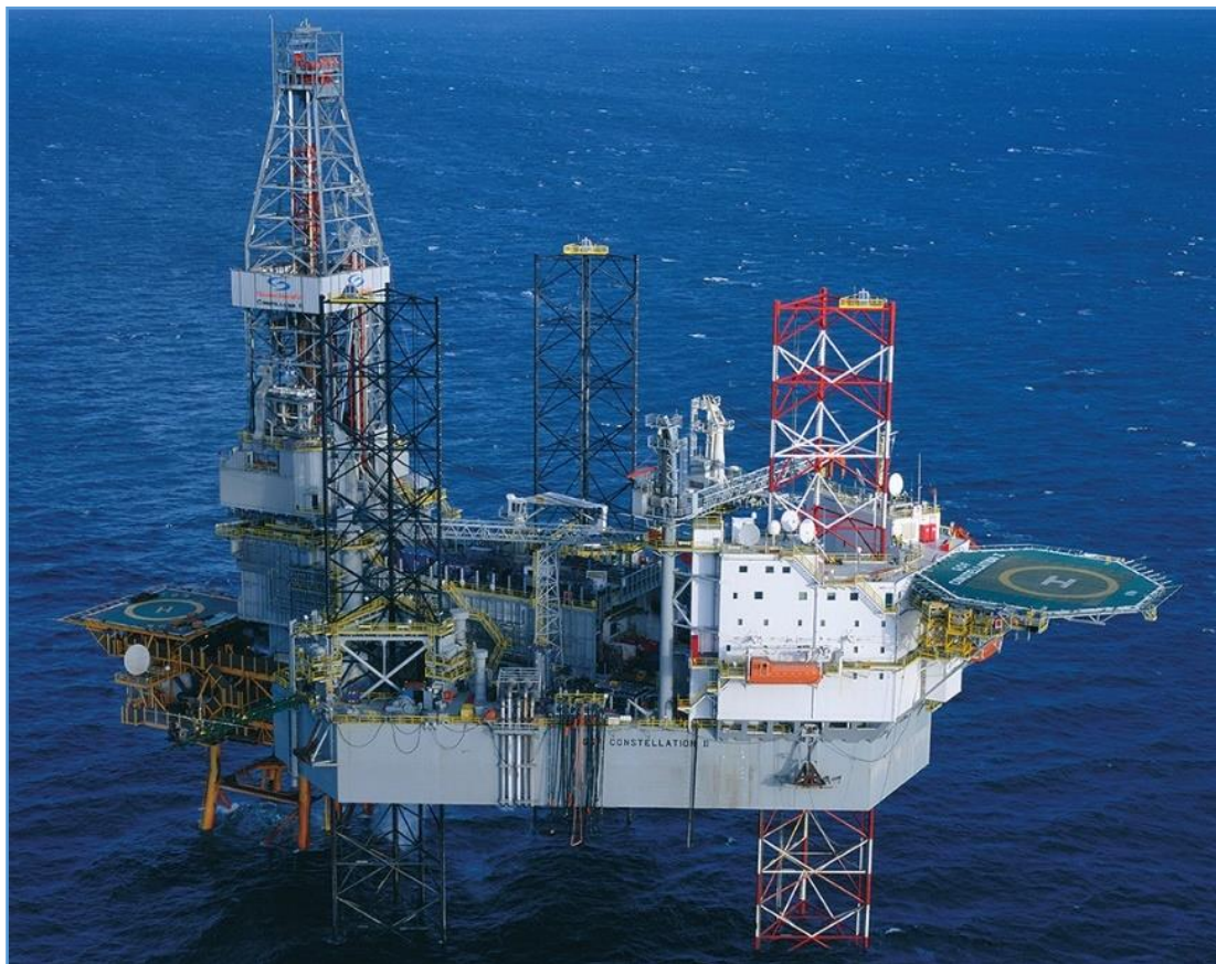
Figura 4.5.3.2.2 Ilustración de la operación de una Jack-up con plataforma de producción, en este caso la Plataforma "Constellation" perforando en aguas argentinas. Fuente: Total Austral
