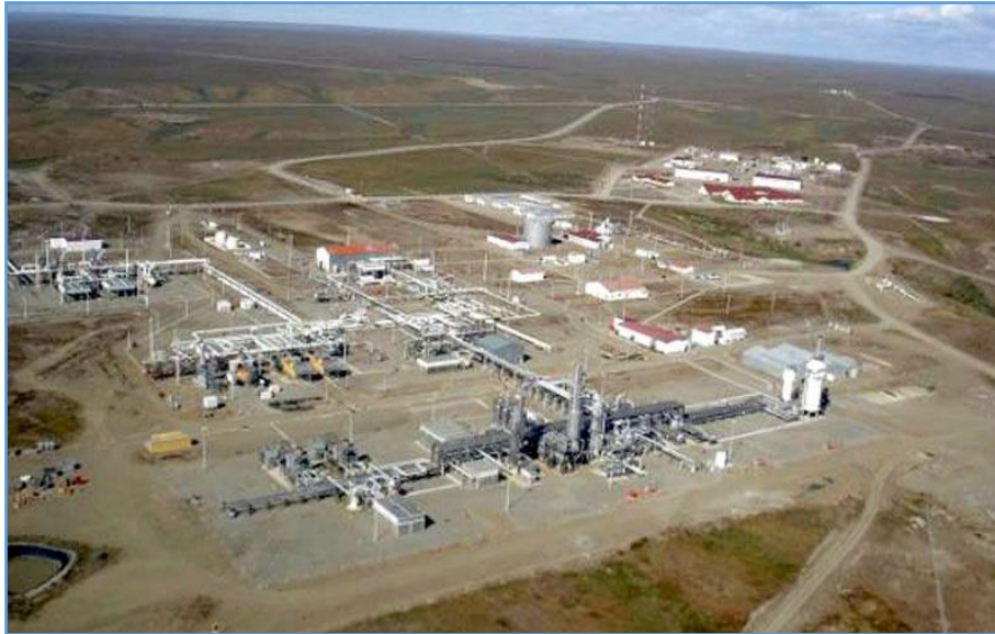
Figura 4.1.3 Planta de tratamiento de gas Cañadón Alfa
