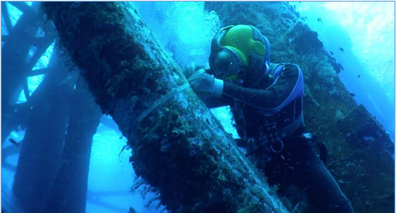
Figura 4.9.2.1.1 Inspección visual de las patas de la plataforma
