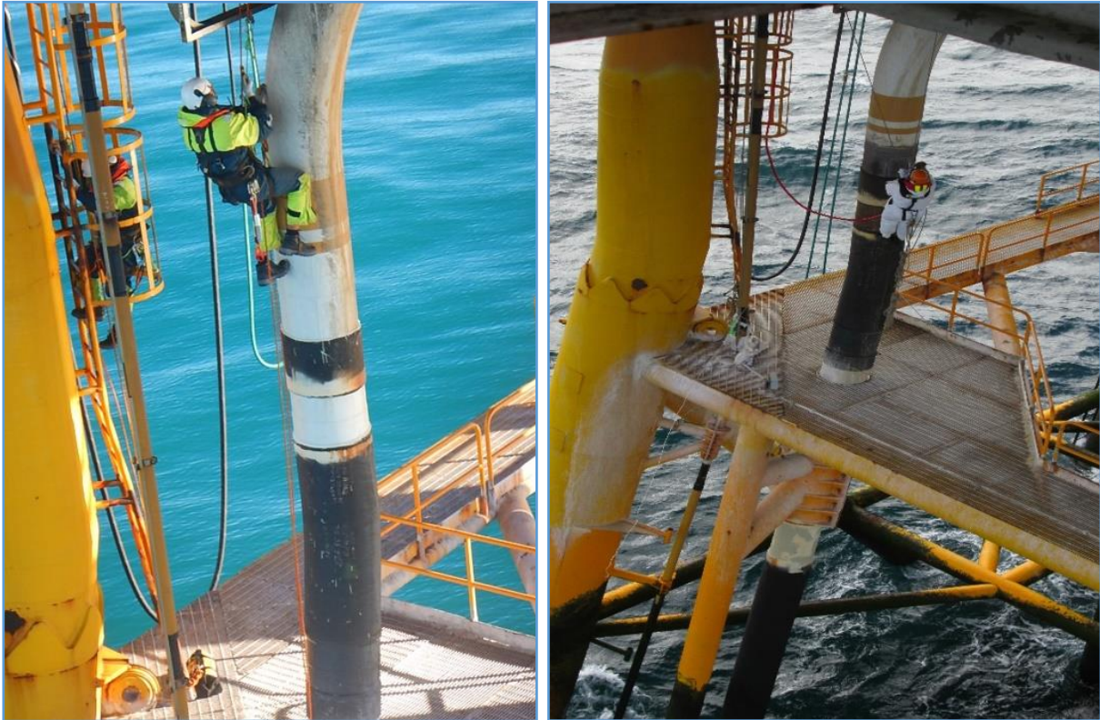
Figura 4.9.3.1 Tareas de mantenimiento de la plataforma. Inspección externa/ pintura en cañería vertical con acceso limitado – Alpinistas -
