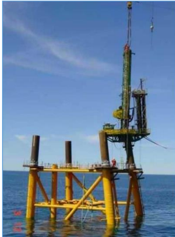
Figura 4.5.1.3.2 Perforación para pilotes para VP. Fuente: Total Austral
