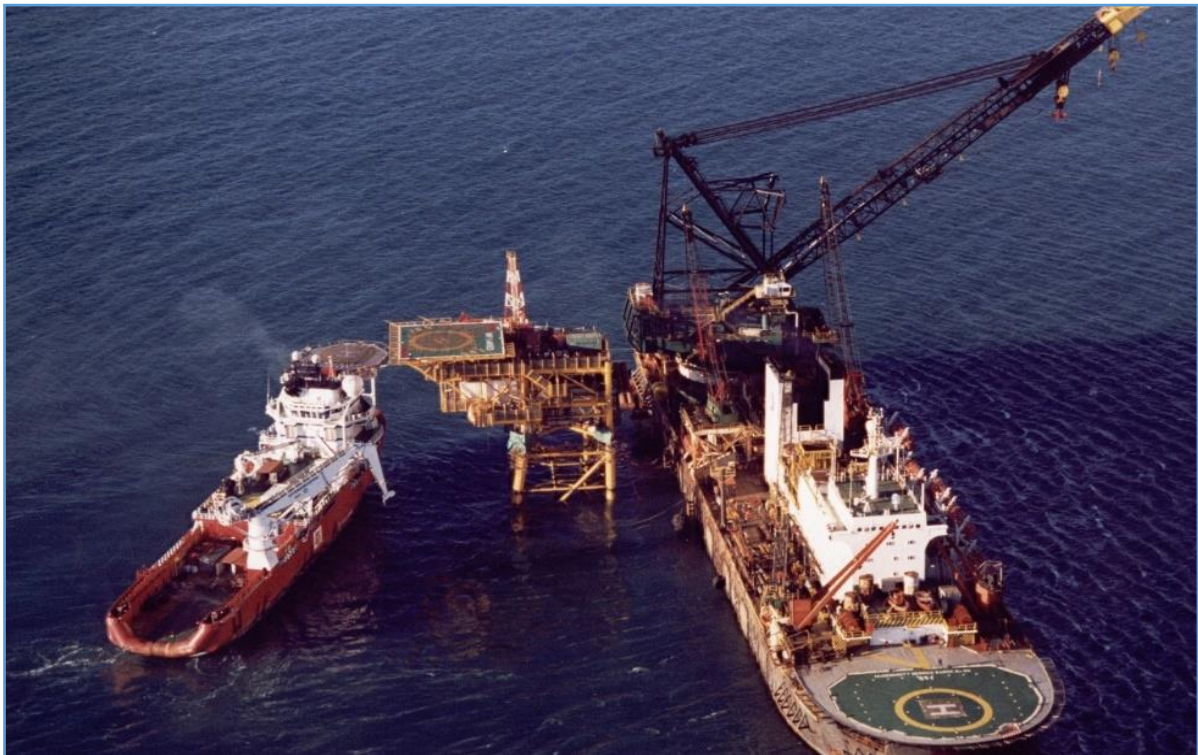
Figura 4.5.1.5.2 Deck instalado sobre la plataforma, buque de soporte o supply y barcaza con grúa. Fuente: Total Austral
