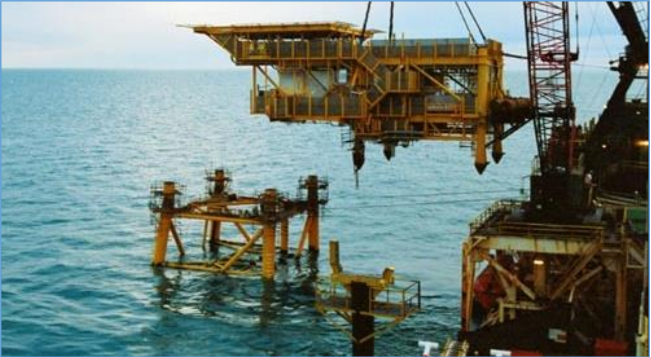
Figura 4.5.1.5.2 Deck instalado sobre la plataforma, buque de soporte o supply y barcaza con grúa. Fuente: Total Austral
