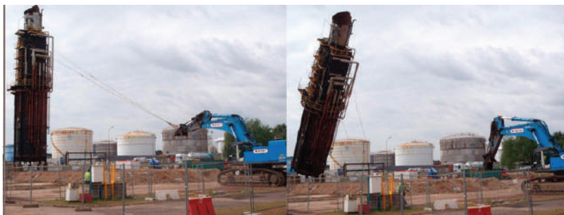
Affalement du four du clarificateur en 2014
