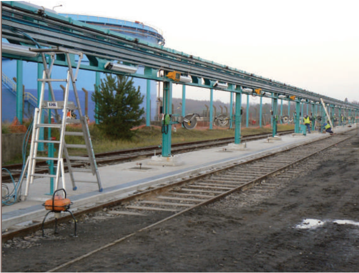
Chantier de construction de la plateforme logistique CAROLINE - 2008
