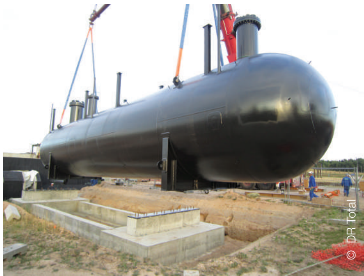
Logistique Butadiène - Pose de la cuve - Juillet 2015
