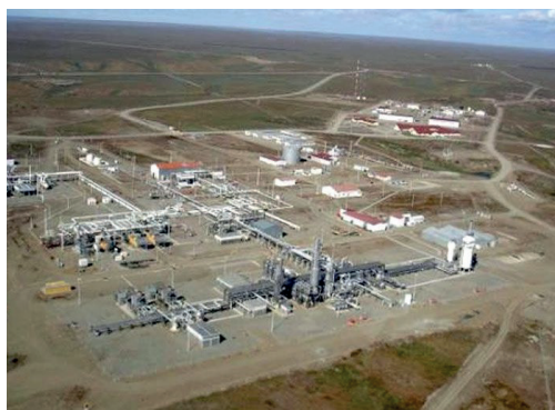
Figura 1.4 Planta de tratamiento de gas Cañadón Alfa Fuente: Total Austral
