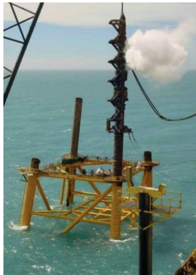
Figura 2.1.1 Hincado de pilotes con martillo de vapor para Vega Pléyade Fuente: Total Austral
