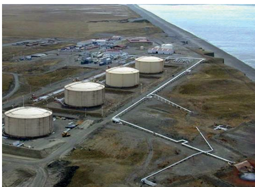
Figura 1.3 Planta de tratamiento de Río Cullen Fuente: Total Austral
