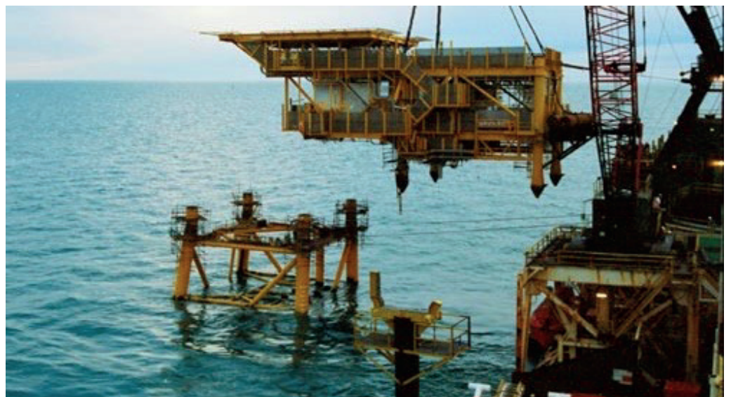
Figura 2.1.2 Izaje del Deck para su instalación sobre el Jacket preinstalado. Fuente: Total Austral
