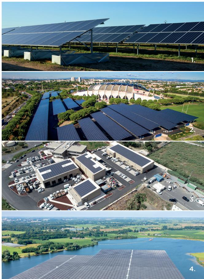
1. **Centrales solaires au sol** : implantation sur friches industrielles, décharges, carrières, zones de stockage, terrains type ZAC et terrains délaissés pour des surfaces à partir de 4 hectares.
