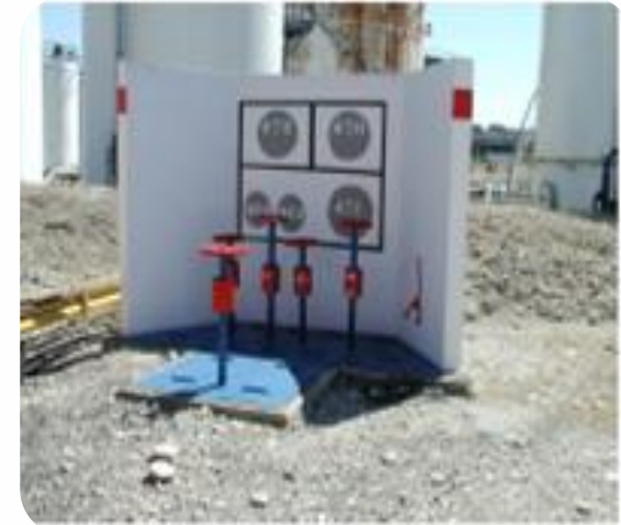
Mur coupe-feu Mur anti-explosion
