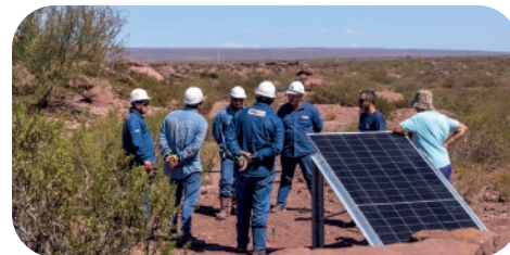
Instalación de paneles solares en paraje Piedra Grande
