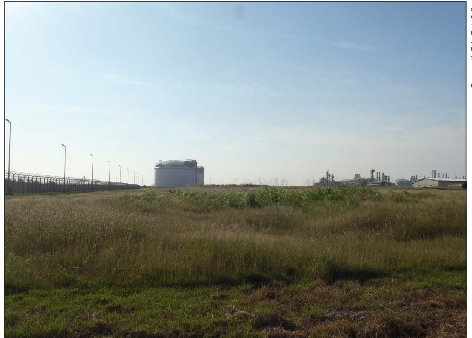
Plate 7.2 LNG Plant site with LNG tanks, looking north
