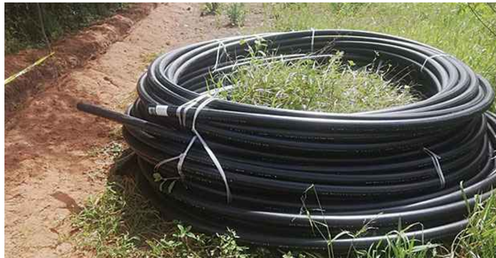
Manguera para la instalación de línea para el sistema de agua
