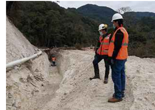
Inspección realizada con Monitor Socio Ambiental Indígena a la ejecución de la Línea de Recolección ICS-5
