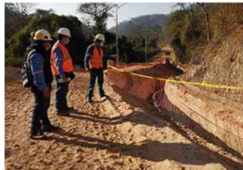
Monitoreo arqueológico excavación de zanja LR ICS-5
