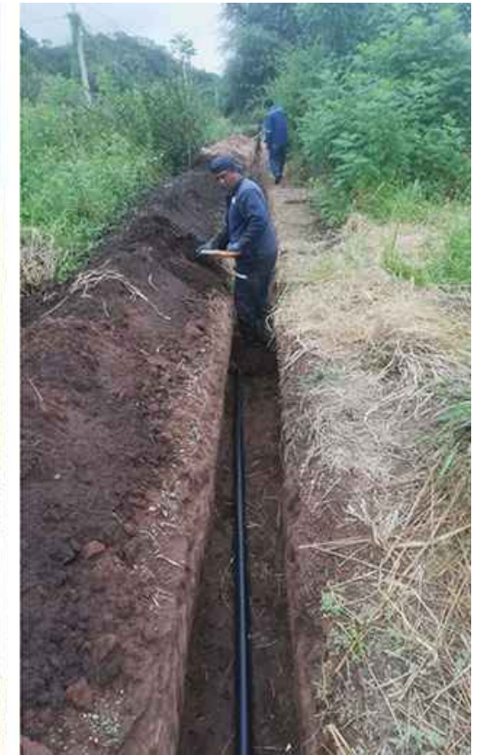
Instalación de línea para el sistema de agua
