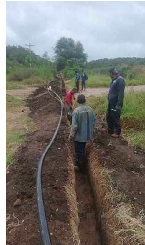
Instalación de línea para el sistema de agua
