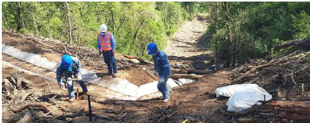
LR ICS 5 trabajos de restauración
