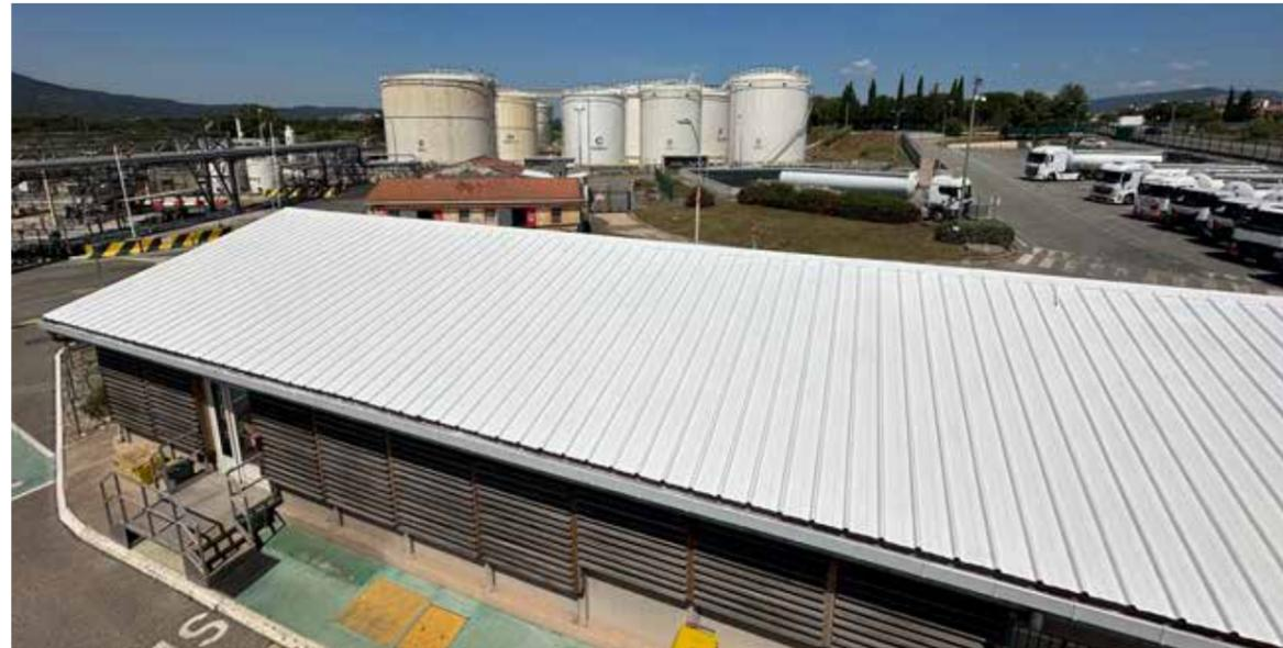
En 2024, la peinture réfléchissante posée sur le toit du Dépôt Pétrolier de la Côte d'Azur (DPCA) a permis de diminuer la température intérieure de 3°C.
