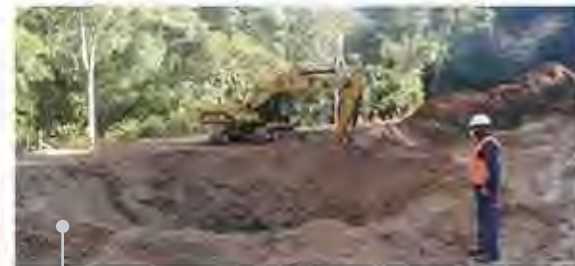
Monitoreo arqueológico a excavación
