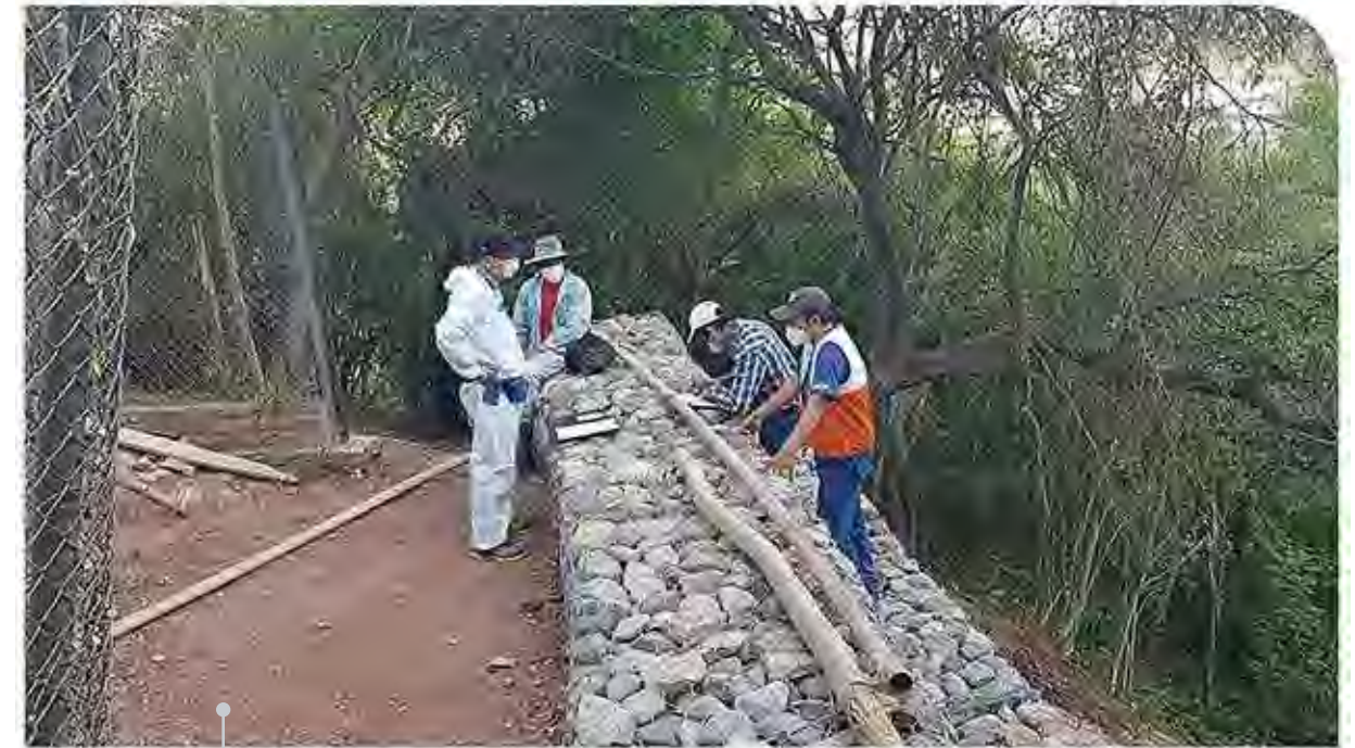
Armado de gaviones en la toma de agua de la OTB Aguada Grande
