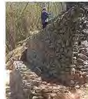
Armado de gaviones en la toma de agua de la OTB Aguada Grande
