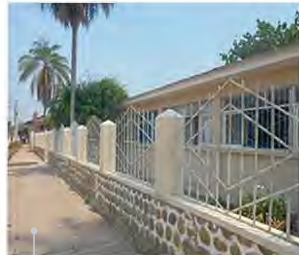
Mejora de la fachada (pintura exterior)
