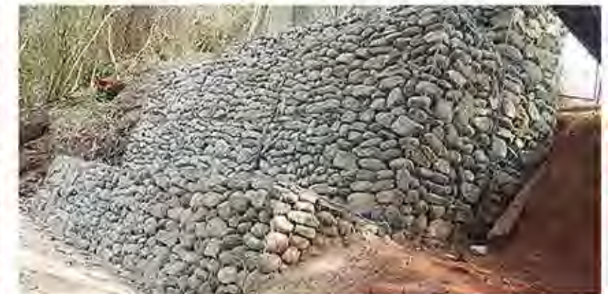
Armado de gaviones en la toma de agua de la OTB Aguada Grande
